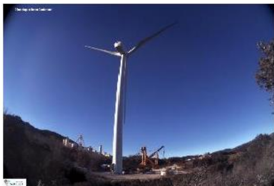
Etape 1 : Montage de la grue sur site
