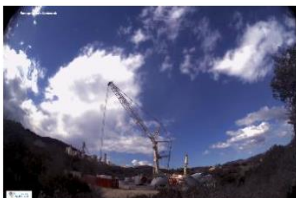
Etape 5 : Démontage complet de l'éolienne
