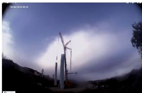
Etape 4 : Démontage des éléments du mât
