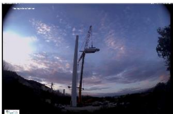
Etape 3 : Démontage de la nacelle et du rotor
