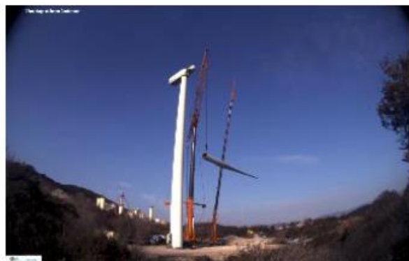
Etape 2 : Démontage des pâles une par une
